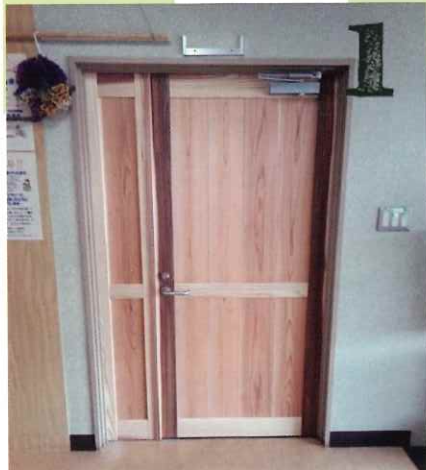
公民館事務所室内建具(鈴鹿市)
